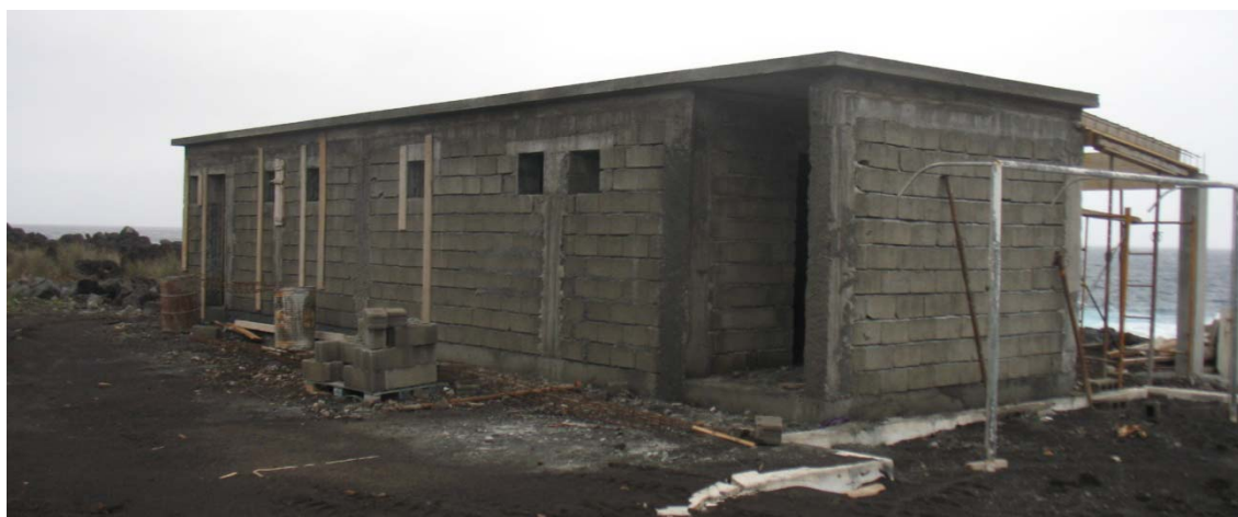
Figura 5.15_Edifício de Apoio em construção na ZB do Calhau
