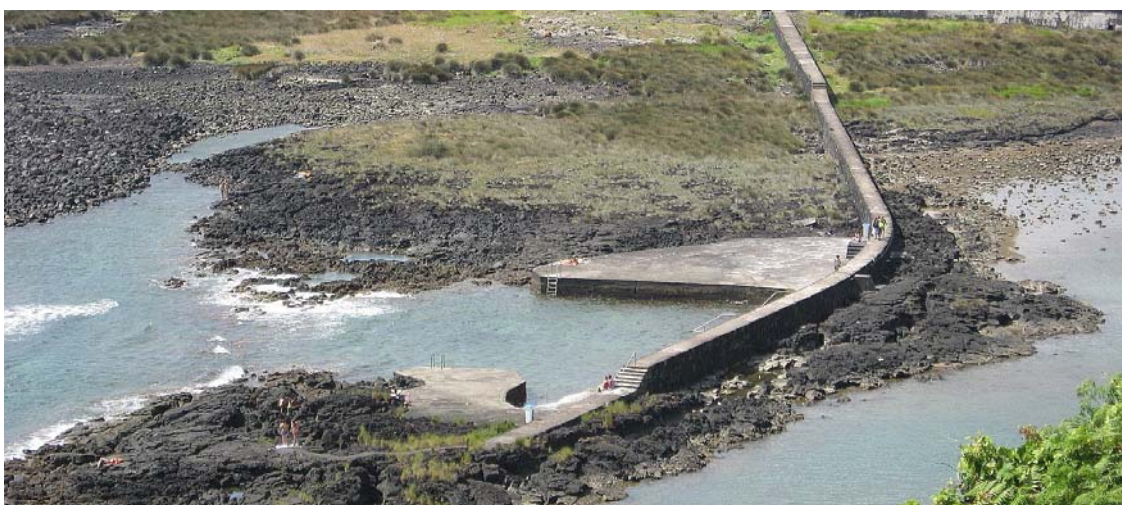
Figura 5.13_Acesso pedonal na ZB da Maré
